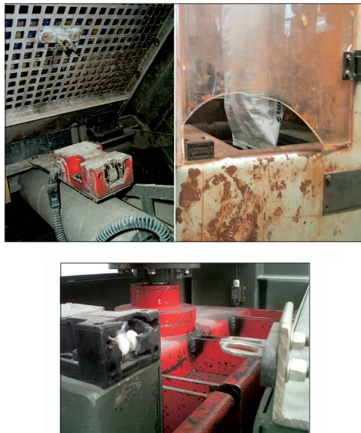
Figura 10: rottura accidentale: interblocco a chiave danneggiato a causa di ripetuti urti per disallineamento dell'attuatore con il sistema di azionamento
